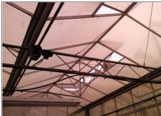
Fotografía 4. Aperturas cenitales del invernadero
