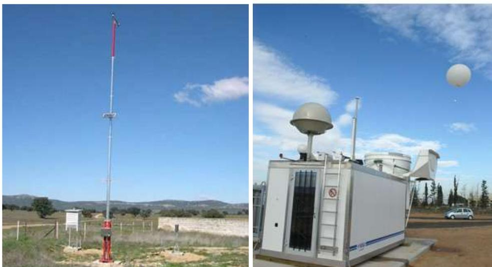
*Figura 3: Estación meteorológica automática de la red meteorológica ordinaria (izquierda), Estación automática para el lanzamiento de radiosondeos (derecha), (Fuente; web de AEMET).*
