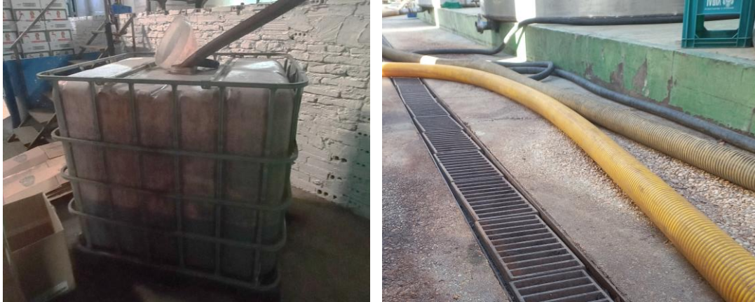
Figura 11. Residuos líquidos generados durante la vinificación en la Vinícola del Condado: (izq.) Estanques IBC con vino y mosto residual en ensayos de laboratorio (der.) Sistema de rejillas subterráneas para la acumulación de vino residual.
