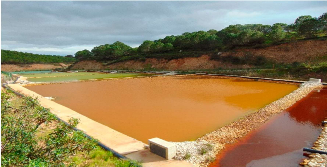
Figura 22. Sistema de humedales artificiales en Mina Lousal (Portugal) (Relvas et al. , 2012)
