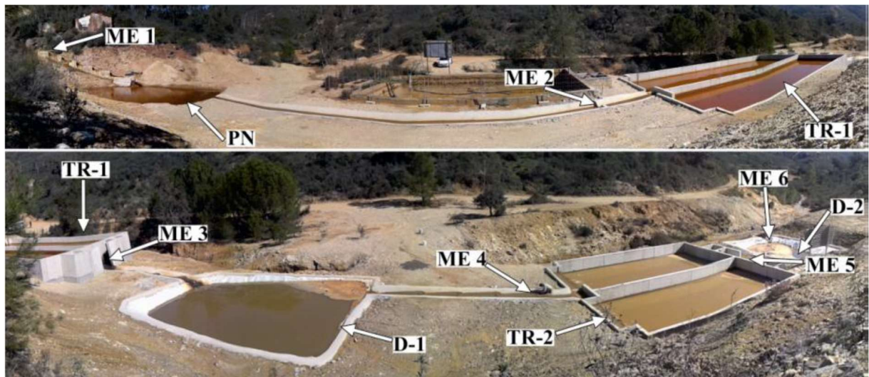
Figura 24. Imagen de la planta de tratamiento DAS de Mina Esperanza: ME-X (Toma de muestra), PN (Pretratamiento), TR-X (Tanques reactivos), D-X (Decantadores) (Nieto et al., 2015)
