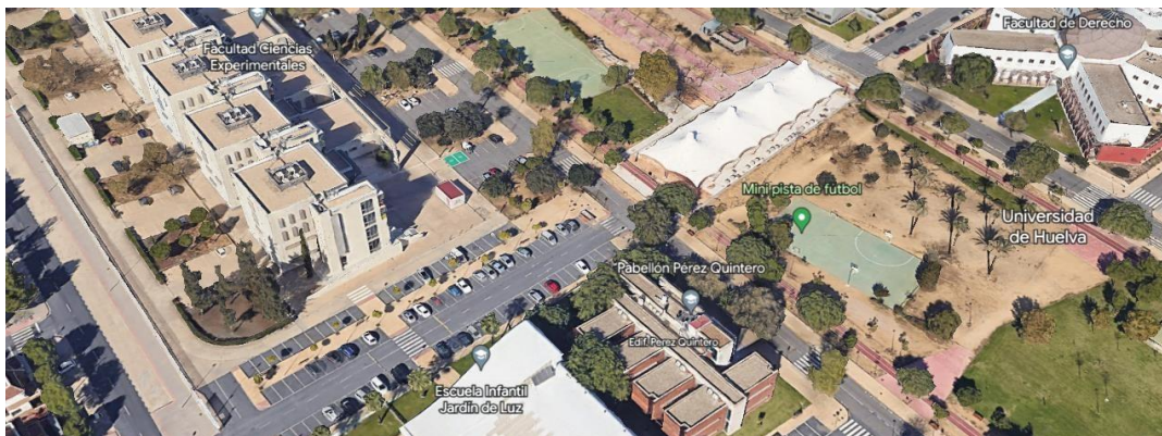
Figura 5: Imagen satelital del Edificio Pérez Quintero en el Campus El Carmen, Huelva
