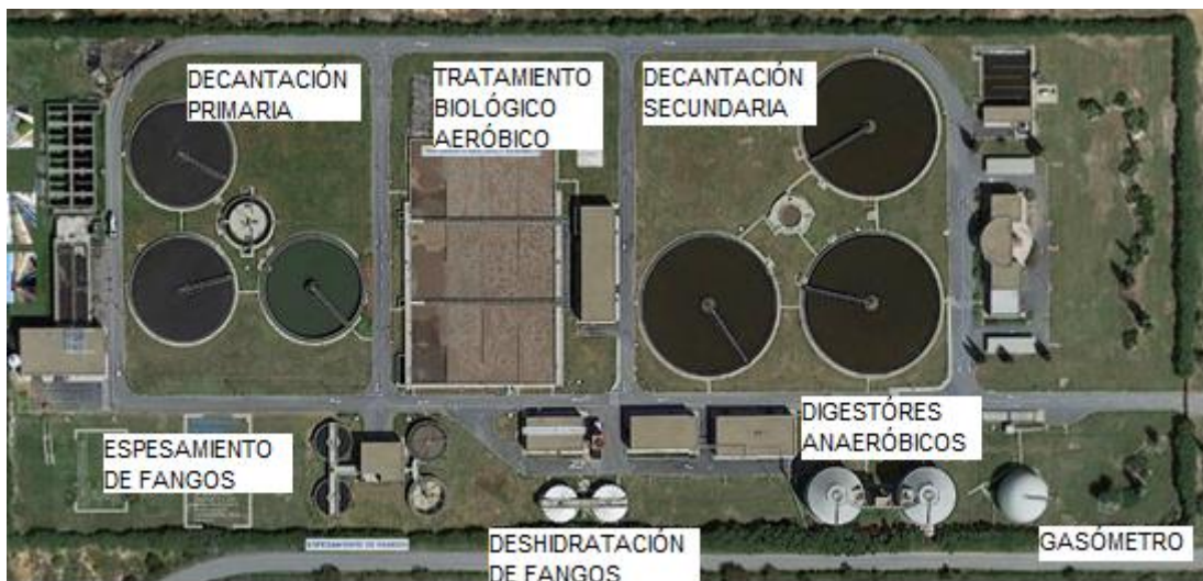
Figura 7: Estación Depuradora de Aguas Residuales (EDAR). (Aguas de Huelva, datos 2023)
