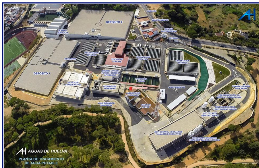
Figura 4: Estación de Tratamiento de Agua Potable (ETAP) el Conquero. (Aguas de Huelva, datos 2023).
