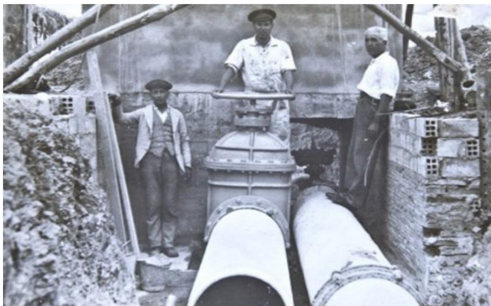
Figura 1: Construcción del pantano del Chanza (Aguas de Huelva, datos 2023).
